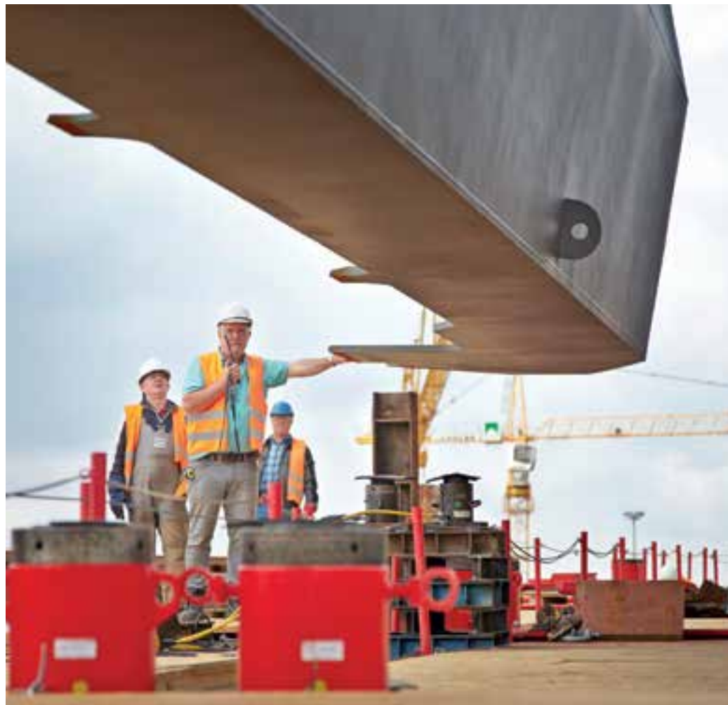
Ein „Schuss“ besteht aus mehreren, miteinander verschweißten Stahlelementen und wird dann per Vorschubverfahren in Position gebracht. Bild: Nadja Wollinsky, Stadtarchiv Ulm
